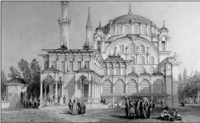
Figure 1: Selimiye Cami, Üsküdar.
